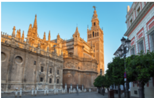
Die Kathedrale ist Spaniens zweitgrößtes religiöses Gebäude mit 145 m Länge und 42 m Höhe.
